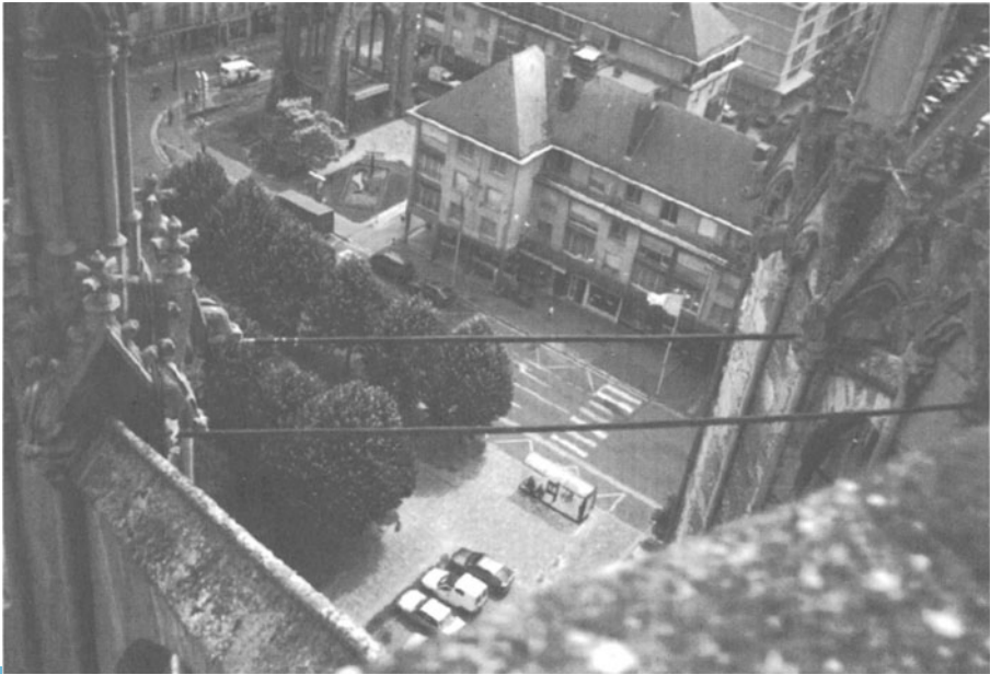
Fig. 4 - Cathédrale de Beauvais : les tirants, côté sud (cliché A. Coste).
